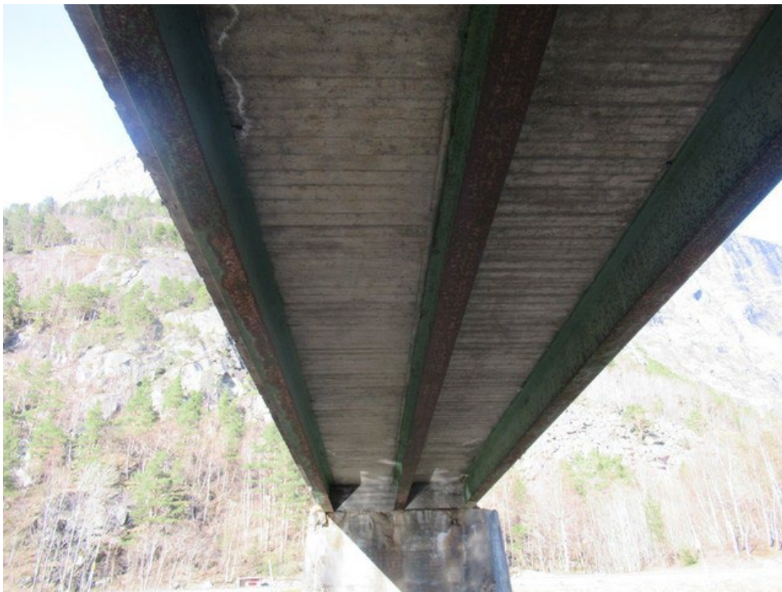
Bilde 7: Hovedbjelker, korrosjon
